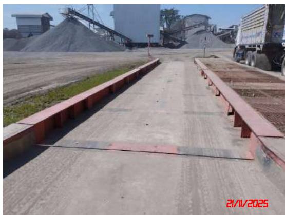
รูปที่ 27 จุดชั่งน้ำหนักรถบรรทุก และป้ายเตือนห้ามบรรทุกเกินน้ำหนักที่กำหนด
